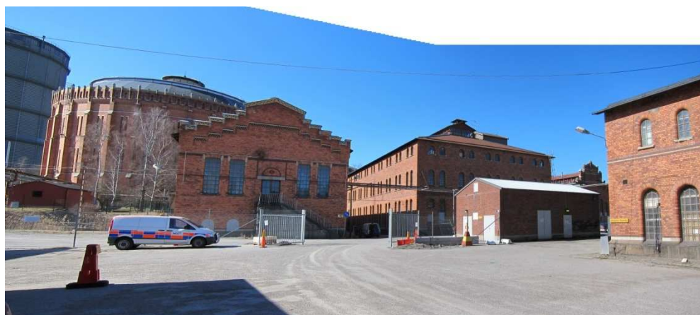
Fotovy i Gasverket. Till höger syns den befintliga transformatorstationen som bedöms möjlig att ersätta med ny bebyggelse (A). Längst till höger syns byggnad 14.
