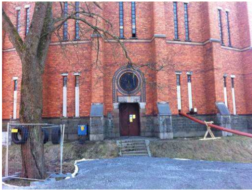
Stentrappa vid entré till gasklocka 1. Bilden visar även den ursprungliga portöppningen med skjutdörrar och mätartavla som ska bevaras enligt q4 ovan.
