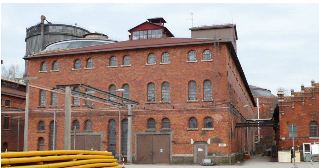
Bild mot östra gaveln av hus 9 med luftledningsstråket i förgrunden samt angränsande hus 10 skymtandes till vänster och hus 8 till höger.
