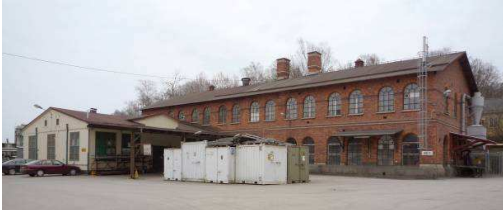
Bild mot norra och västra fasaderna av hus 13.
