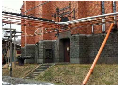
Stentrappa vid entré till gasklocka 2. Bilden visar även den ursprungliga portöppningen med skjutdörrar och mätartavla som ska bevaras enligt q3 ovan.
