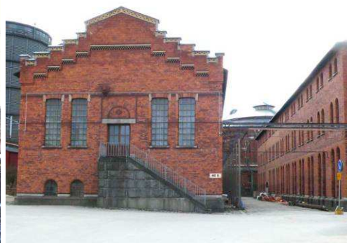
Trappan framför hus 10. Bilden visar även tegelfasader, tegelutsmyckning, stendetaljer och stenuksmyckning samt fönsteröppningar med bågar och karmar som ska bevaras enligt q8 ovan.
