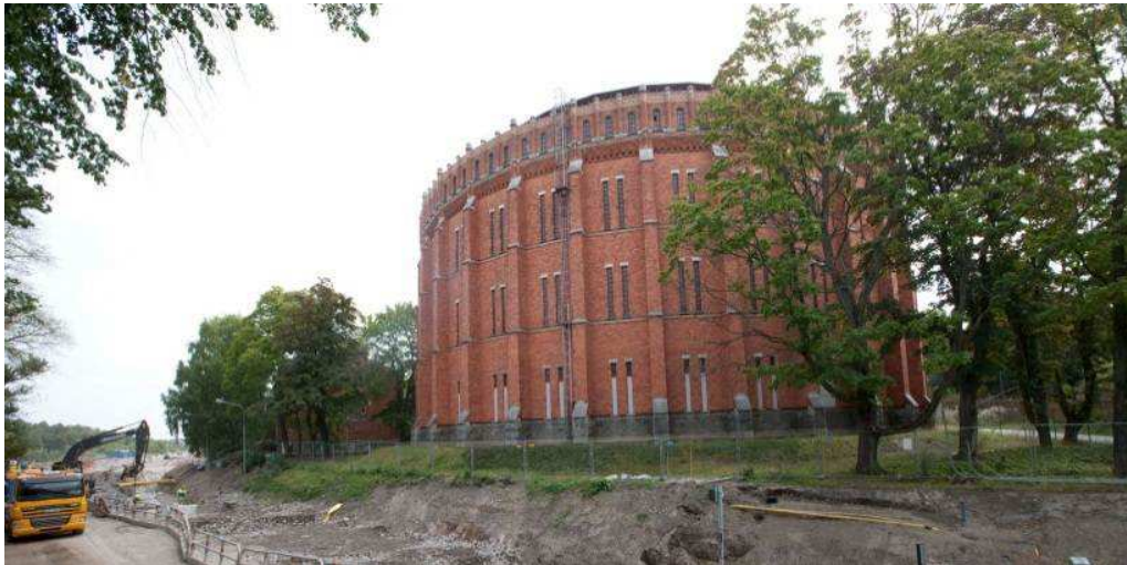
Foto på Gasklocka 1 och anläggandet av Bobergs gata i sep 2013.
