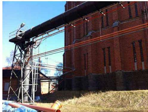
Bild luftledningsstråk mellan gasklocka 1 och 2.
