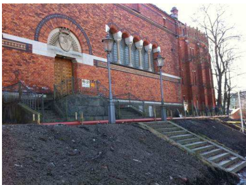
Gaslyktor och stentrappor framför hus 7. Bilden visar även tegelutsmyckning, stensockel, stendetaljer, dekorativ sten, fönsteröppningar samt portöppning med dörrblad som ska bevaras enligt q5 ovan.
