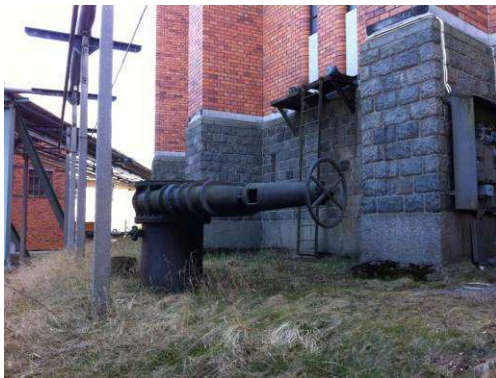
Bild gasregulator invid gasklocka 2.
