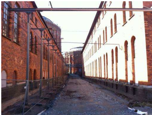
Bild luftledningsstråk mellan hus 9 och 10.
