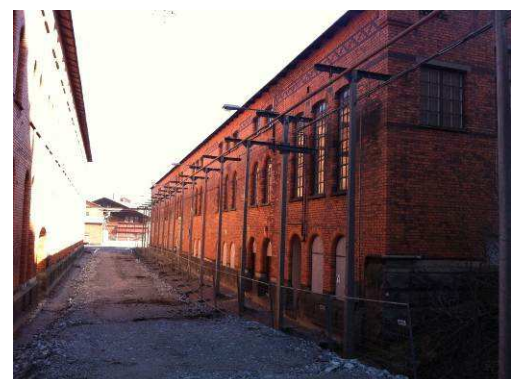
Luftledningsstråket mellan hus 9 och 10.
