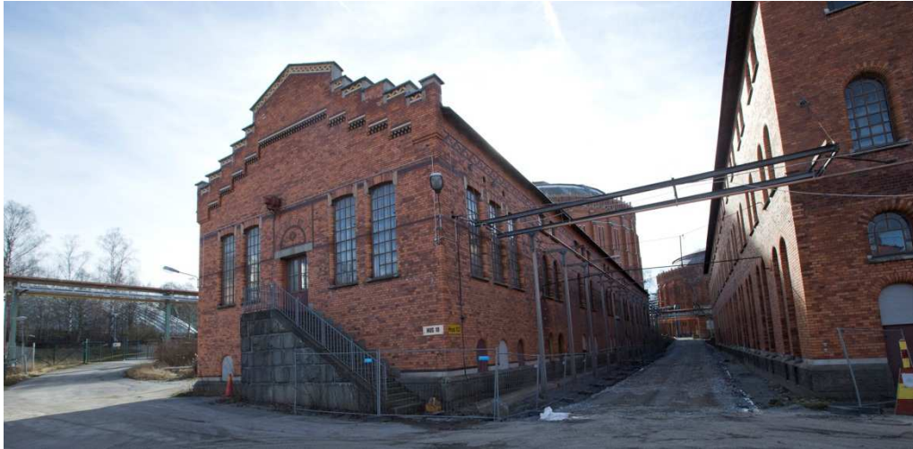
Bild mot östra gaveln samt norra fasaden av hus 10. Bilden visar även gränden mot hus 9 (till höger i bild) med luftledningsstråket.
