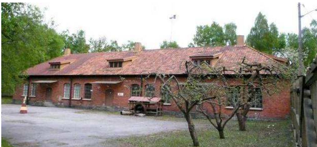
Bild mot den norra fasaden av hus 11.
