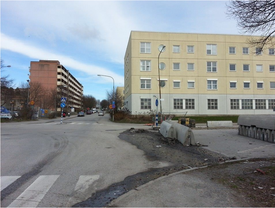
Korsningen - Rinkeby Alle, Rinkebysvängen där rondellen ska byggas
