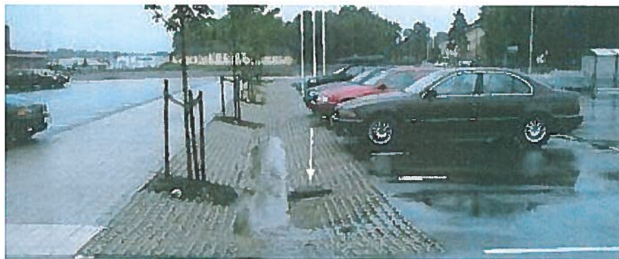
Figur 10. Exempel på fördröjningsstråk. Notera att dagvattenbrunnen ligger högre än botten och därmed skapas en magasinvolym. (Svenskt Vatten, 2011)
