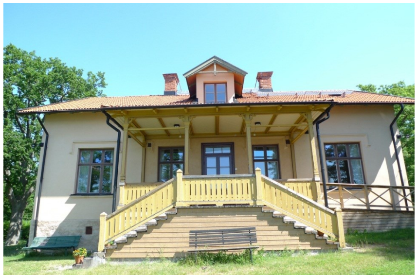
Ingenjörsvillan, mot vattnet
