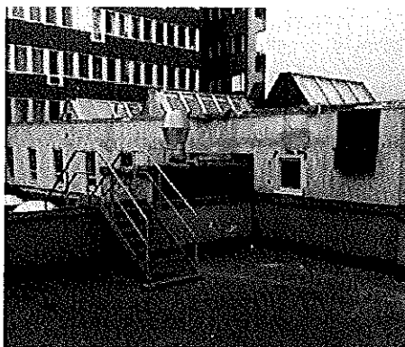
Figur 2: Garage- och konferensrumsfläkt tillhörande grannhuset som bedriver hotellverksamhet
