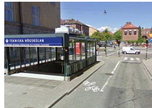
Vid entréområdet till KTH finns stora gångtrafik stråk mellan tunnelbana, bussar och Roslagsbanans station och KTH-området.
