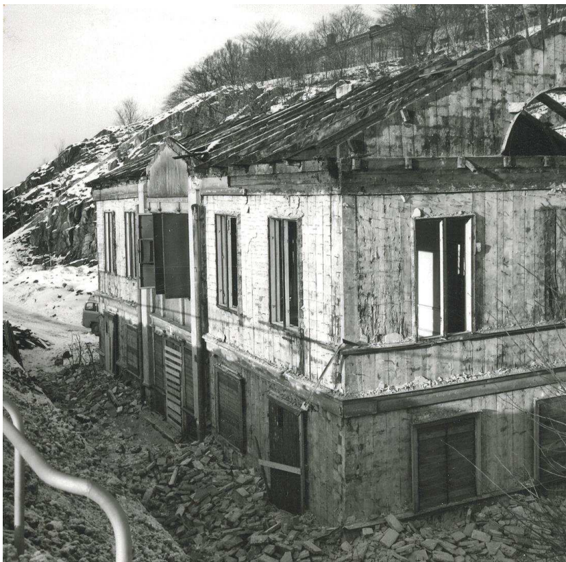
Tullhuset vid Roslagstull under nedmontering 1965. Foto G. Fogde, SSM F77865.
