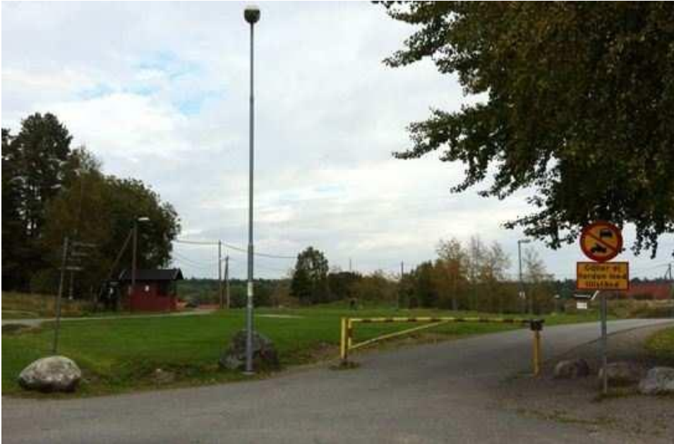
Befintlig spårcentral och vägbom vid huvudentrén till Alby naturreservat
