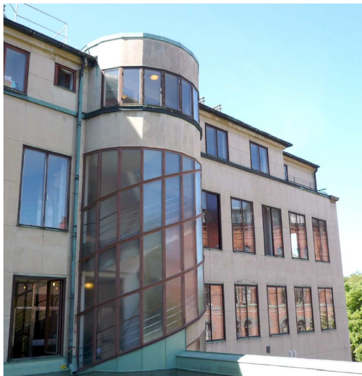
Det unika trapphustornet med fönsterband som följer trappans spiral. Foto ur Nyréns antikvariska förundersökning 2008-12-19.
