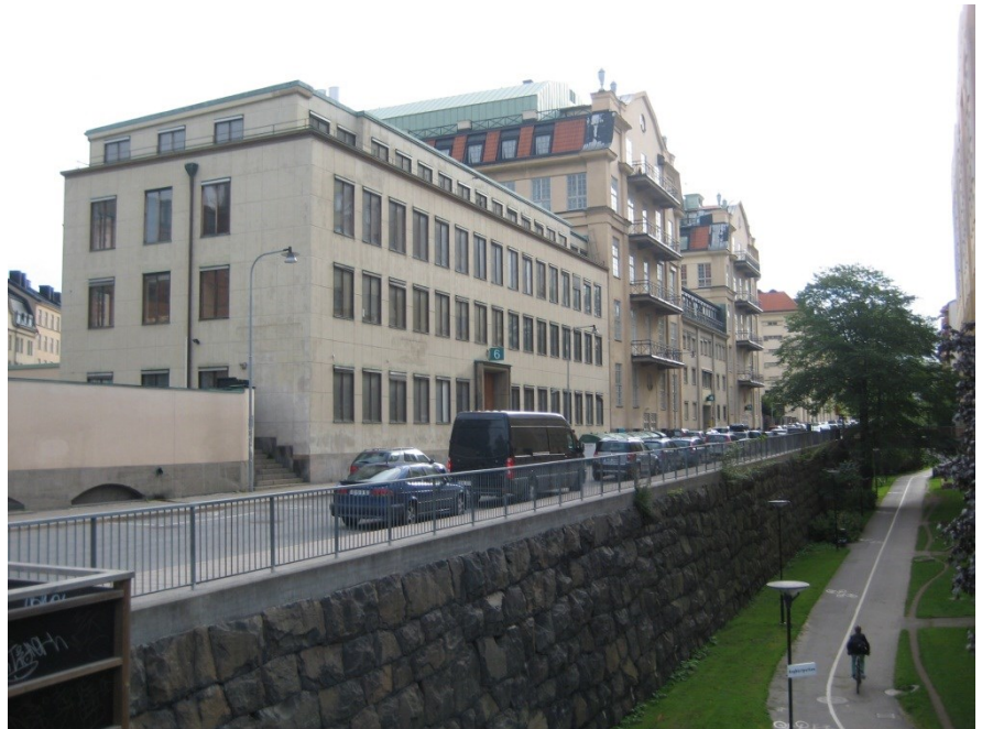
Tobaksmonopolets f d huvudbyggnad 2014. Foto Mari Ferring, Stadsmuseet. Huset har en funktionalistisk utformning, med en kubliknande form, platt tak med indragen takvåning, en imponant stenportal mot gatan och en spiralformad utanpåliggande trappa mot gården.
