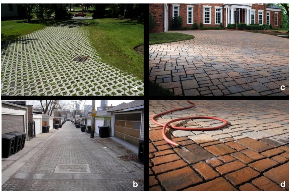
Figur 13. Exempel på genomsläppliga material för hårdgjorda ytor (källor b: www.fhwa.dot.gov ; c och d: www.belgard.biz ).
