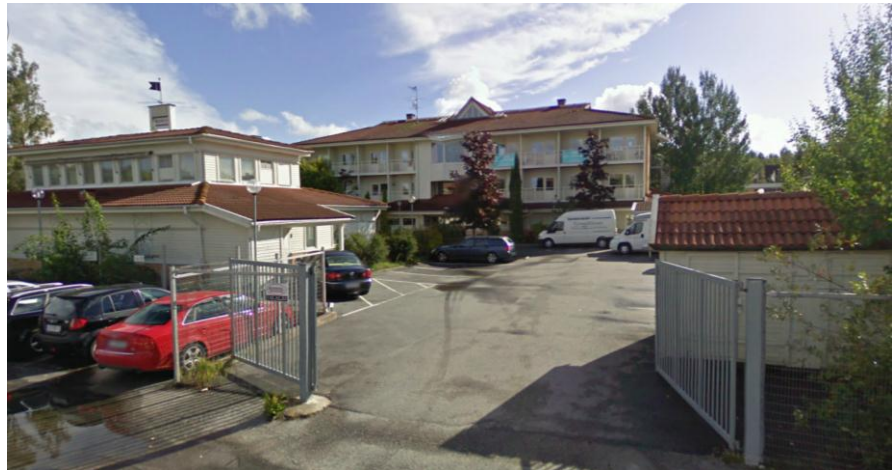
Fastigheten sedd från nordväst.
