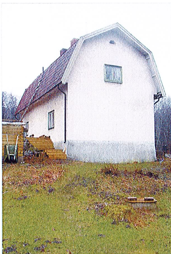
Från nordväst. På gaveln skymtar spår av ett igensatt fönster.
