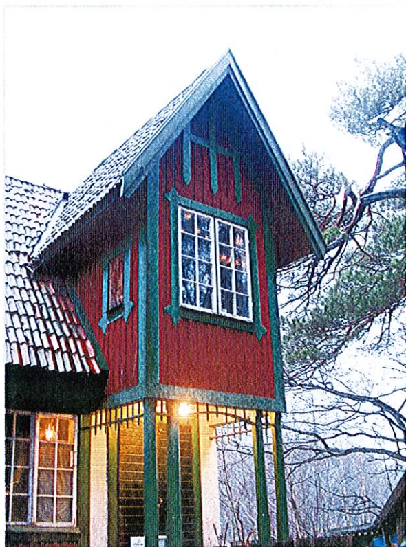
Övervåningens utbyggnad över entrén.
