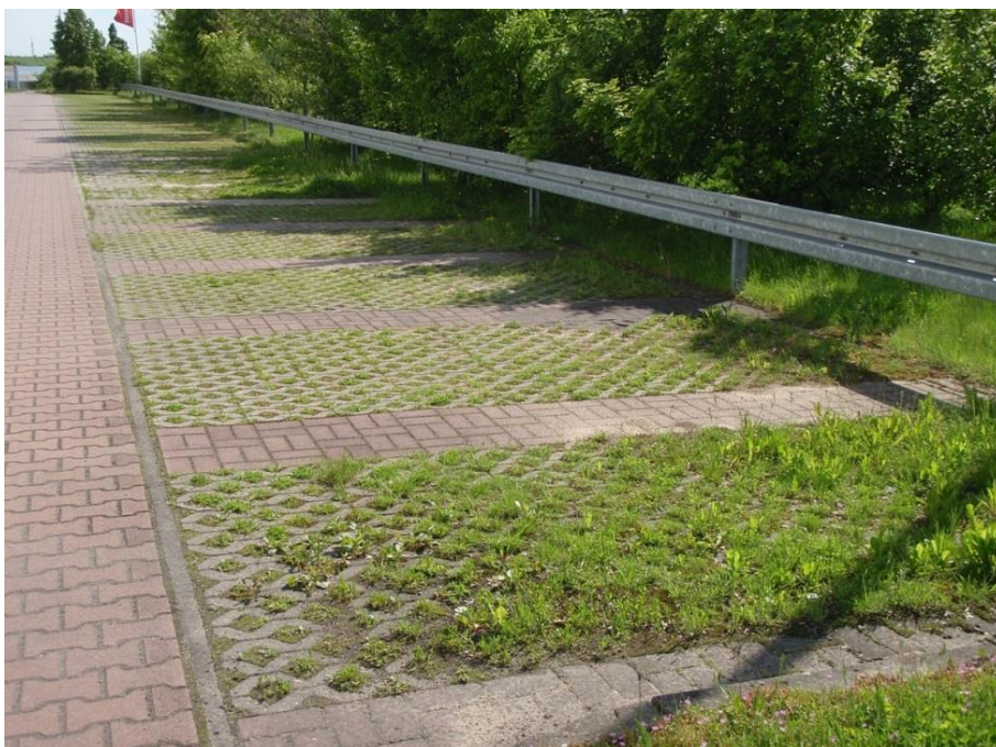
Figur 12. Infiltrerbara, gröna parkeringsrutor utformade med betonghålsten.
