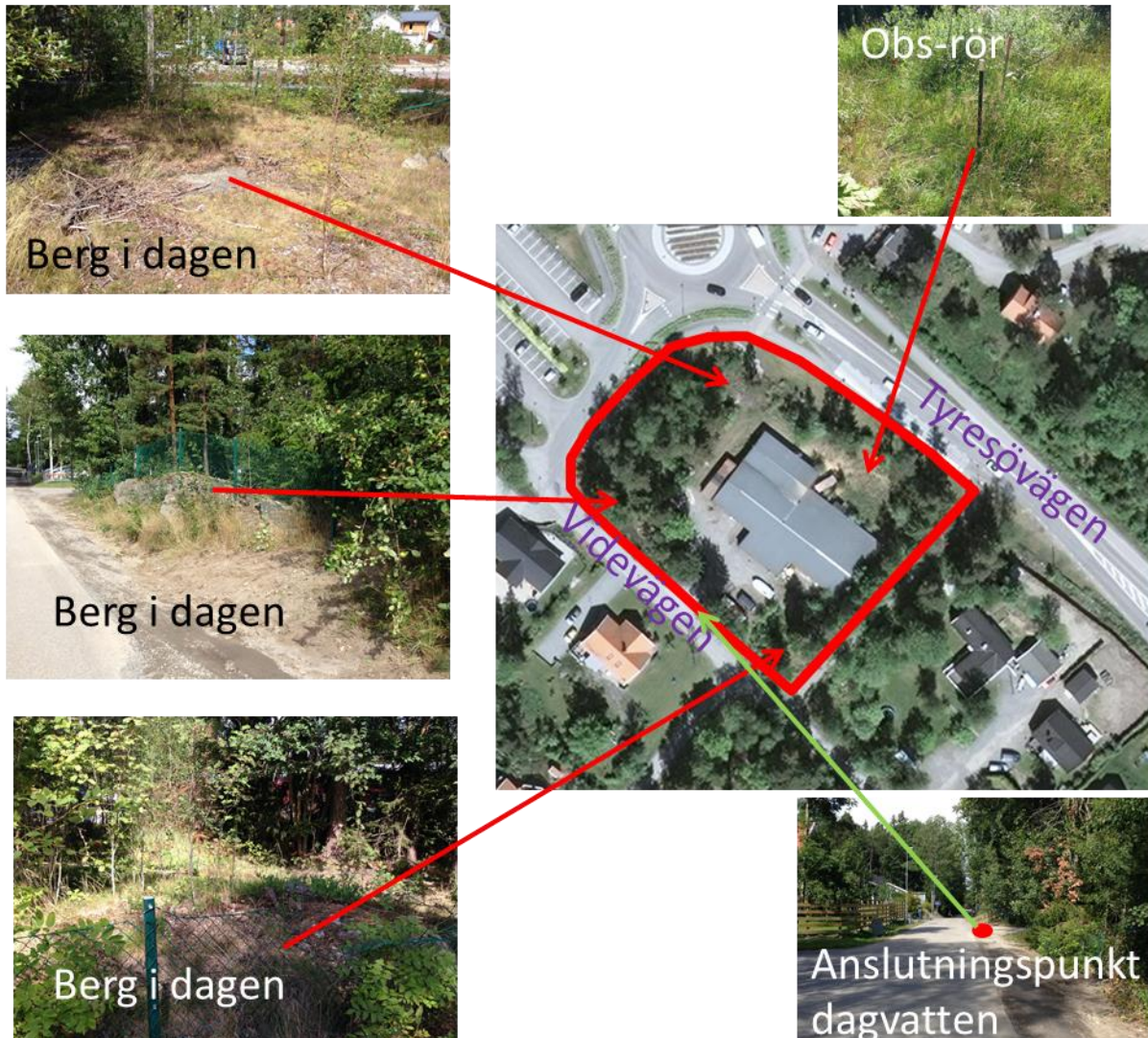
Figur 1. Jordlagermäktigheten är liten. Berg i dagen finns på ett flertal ställen inom den aktuella. Mäktigaste jordlagermäktigheten uppgår som mest till 3,7 m. Befintlig dagvattenledning finns i Videvägen. Angiven anslutningspunkt till dagvatten ligger vid nuvarande infart till fastigheten. Dagvattenledningens flödesriktning är mot nordost och nivån på ledningen är således lägre vid fastighetens västra hörn.
