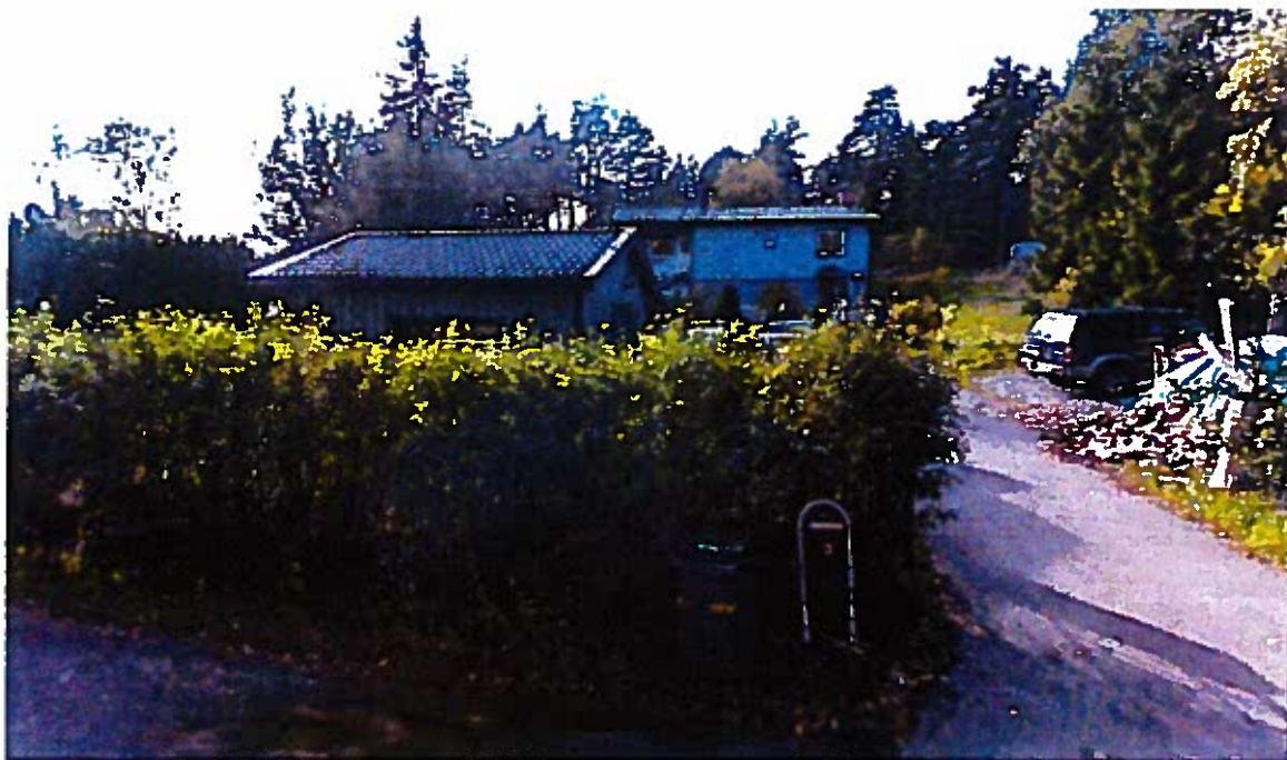
Fastigheten Kumla 3:242, Malmstigen 3
