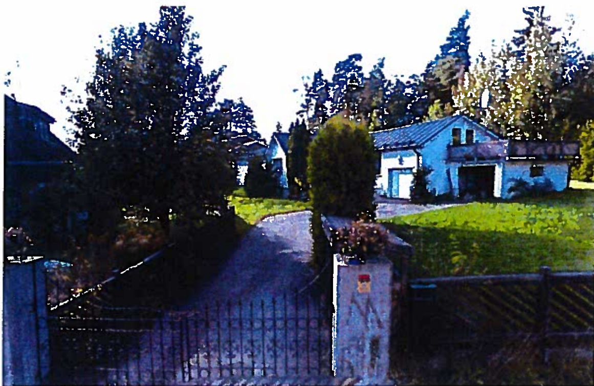
Fastigheten Kumla 3:245, Malmstigen 1
