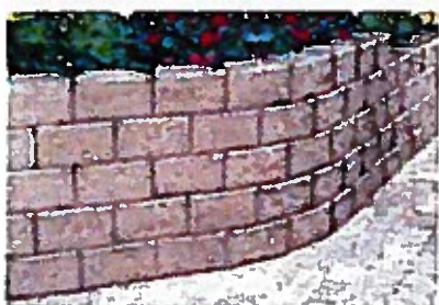
Exempel på stödmur
