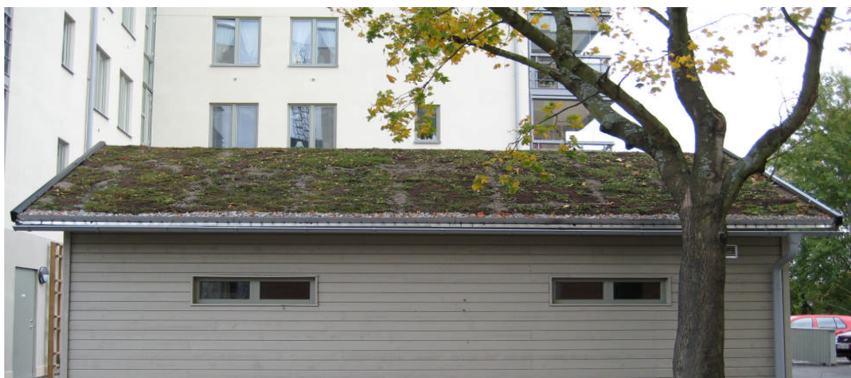
Sedumtak, en metod för lokalt omhändertagande av dagvatten
