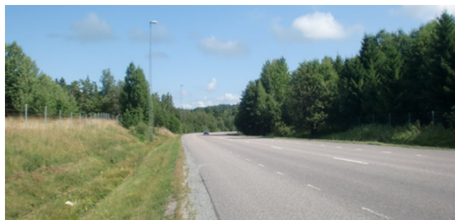
Bred vägbana på Gamla Skärgårdsvägen (väg 622)
