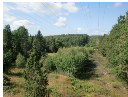
Befintlig kraftledning i västra Kil
