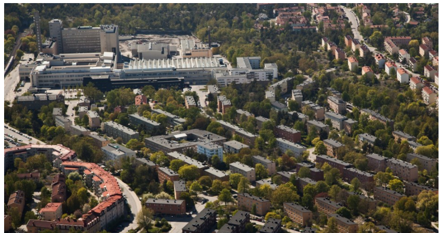
LM-staden. Överst i bild telefonfabriken med Designens hus i svart. Foto SSM
