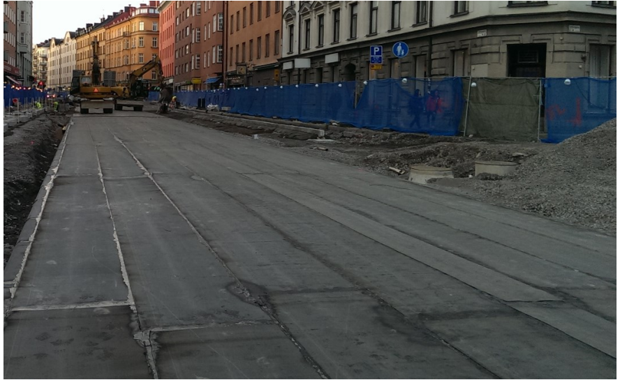
Däckets översida med tätskikt för att skydda betongen
