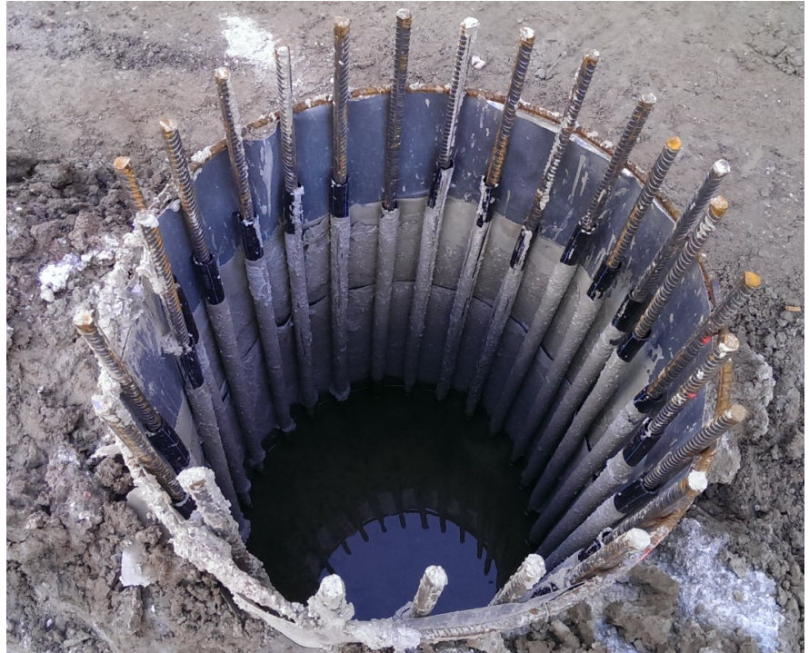
Schakt för påle sedan armeringskorgen monterats.
