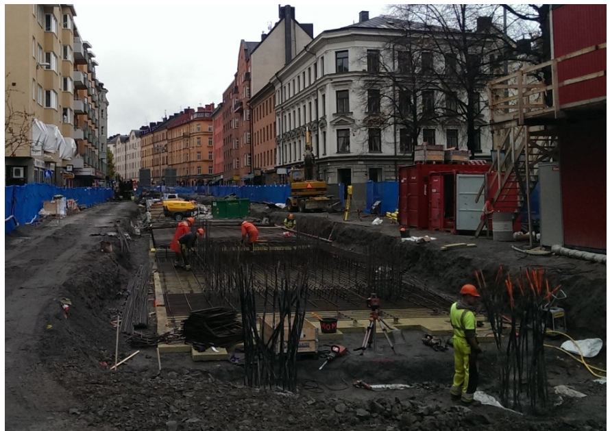
Schakt för däck, uppstickande armering från pålar. Vy mot väster.
