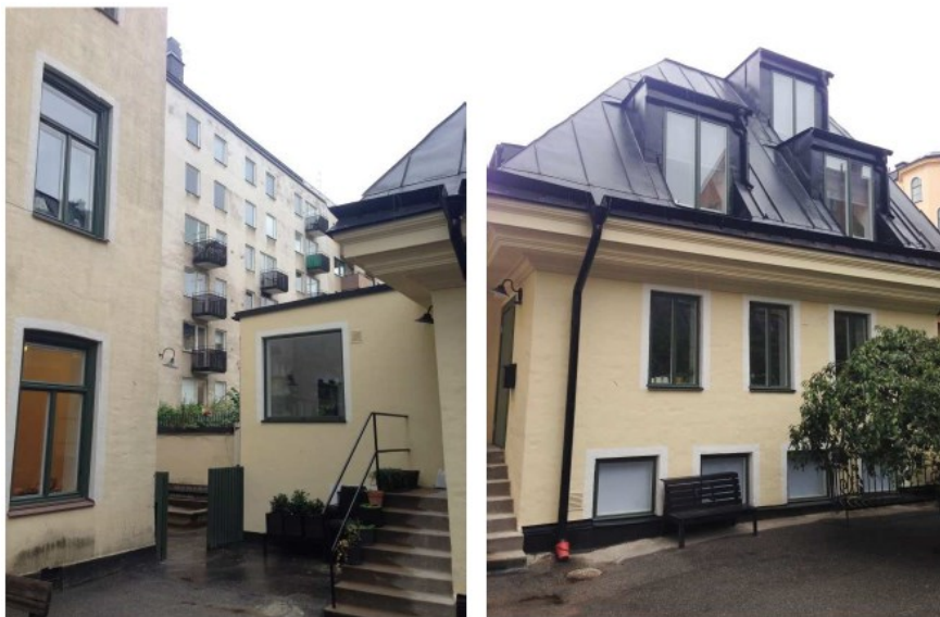
Till vänster den genomförda tillbyggnaden i förhållande till flygelbyggnad. Till höger de genomförda takkuporna istället för takfönster.
