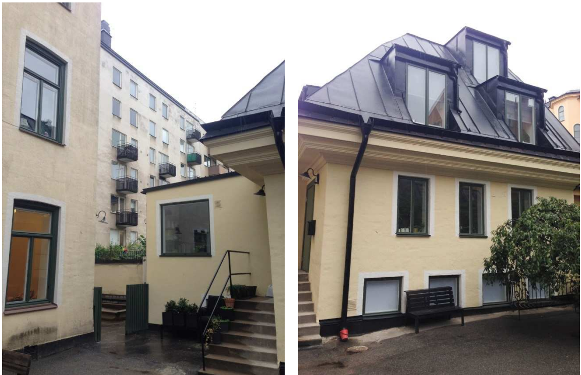
Fasad mot söder. Till vänster: den genomförda tillbyggnaden i förhållande till flygelbyggnad. Till höger: de genomförda takkuporna istället för takfönster.
