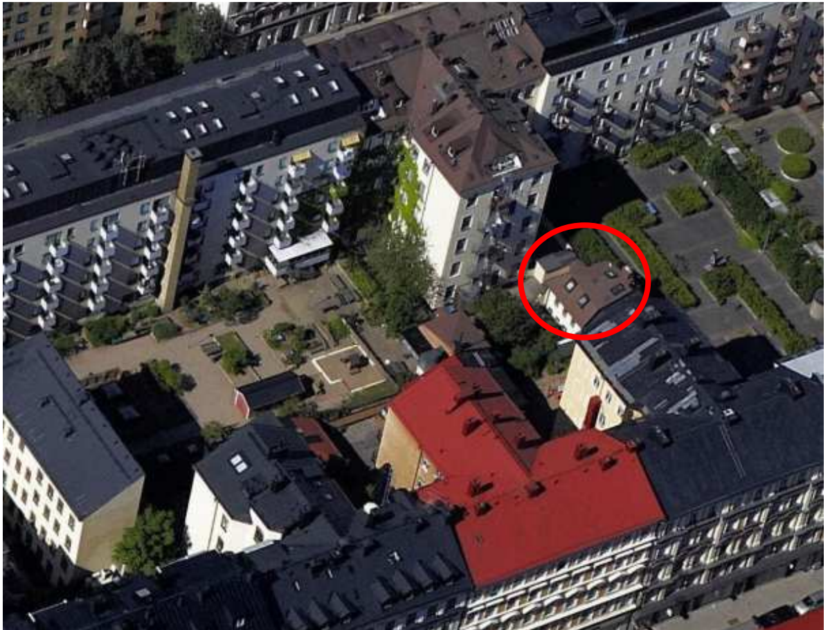
Flygfoto över kvarteret Sirius. Det befintliga gårdshuset markerat med röd ring. Intill gårdshuset syns den komplementbyggnad som har rivits och ersatts med en tillbyggnad.
