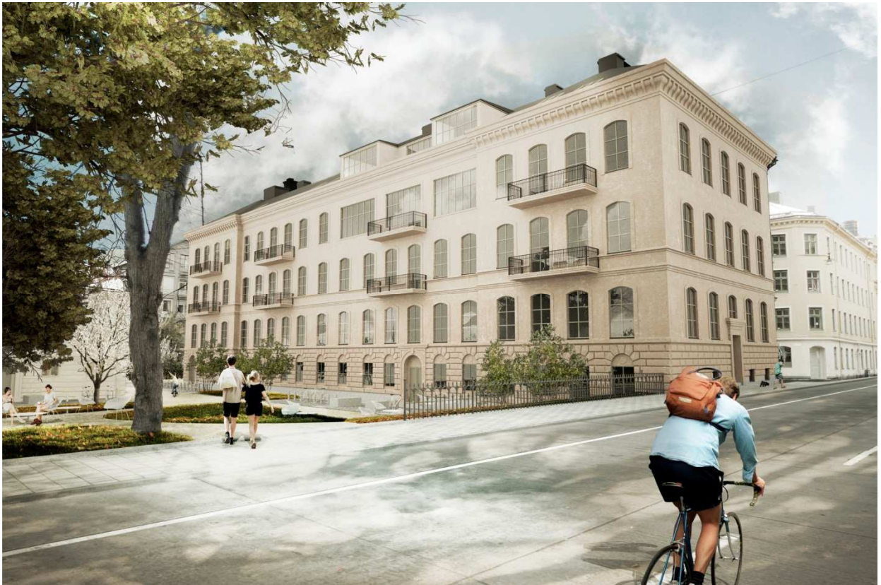
Vy från Kungstengatan. Mot gårdssidan föreslås Laboratoriebyggnadens fasad kompletteras med ett antal balkonger, ett par takkupor och en takterrass. Takkuporna och altanen motsvarar de större fönstren från 1920-talet i våning 3 trappor.
