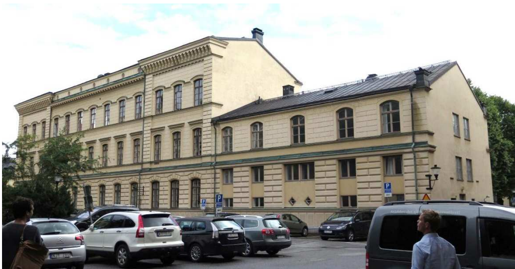
Materialprovvningsanstalten, befintlig fasad mot norr. Liksom den äldre Gamla Teknis huvudbyggnaden har huset en dekorerad huvudfasad mot norr.
