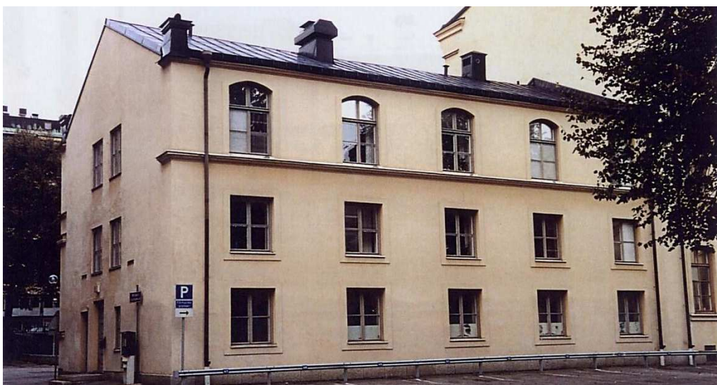
Materialprovvningsanstalten, befintliga fasader mot söder och väster är i princip helt slätputsade.
