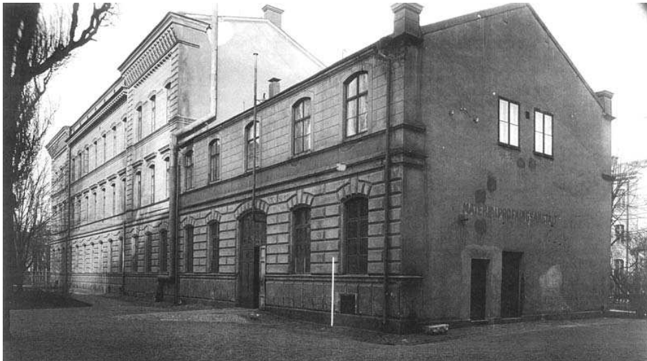
Materialprovningsanstalten, den ursprungliga fasaden sett från norr. Foto 1928 i Byggnadsstyrelsens bildarkiv.
