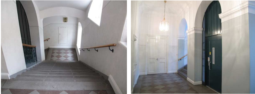
Det norra trapphuset, kalkstensgolv, smidesräckan och valvöppningar med putsdekorer vid anfang och mot tak.
