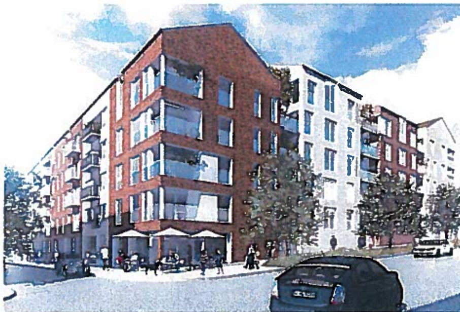
Kv. 5a och 5b
