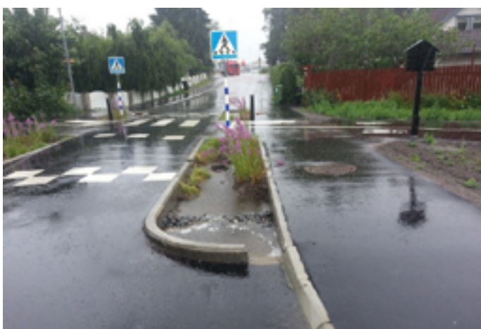
Bild 3.11 och 3.12: Anläggning på Öringevägen, efteråt. De gröna infiltrationsytorna smalnar av vägen till ett körfält vid en upphöjd gång och cykelpassage.
