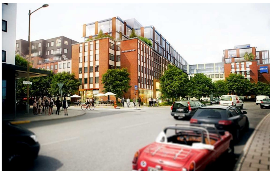
Bild 1. Förslaget sett från korsningen Tegeluddsvägen - Sehlstedtsgränd. Till vänster syns grannfastigheten med sin nya påbyggnad med bostäder. Bild: White arkitekter
