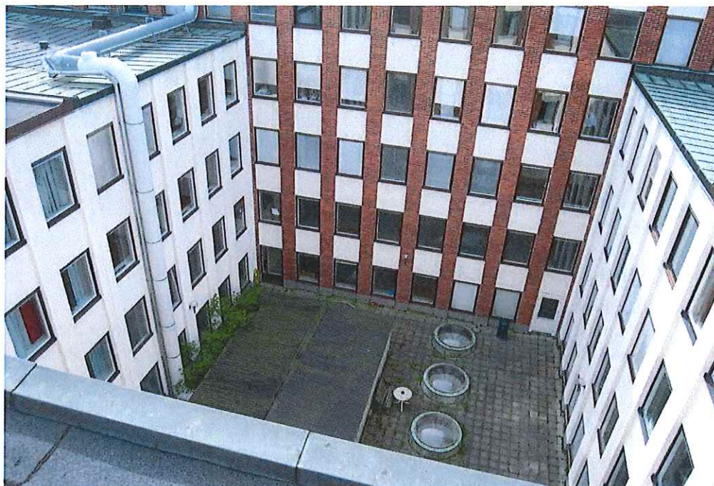
Befintlig innergård i väster
