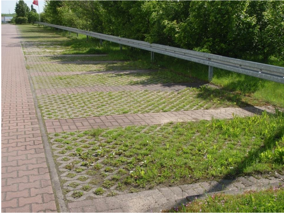
Figur 12. Infiltrerbara, gröna parkeringsrutor utformade med betonghålsten.
