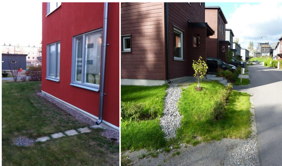
Figur 9. Exempel på utkastare och avledningsstråk från bostadhus.
