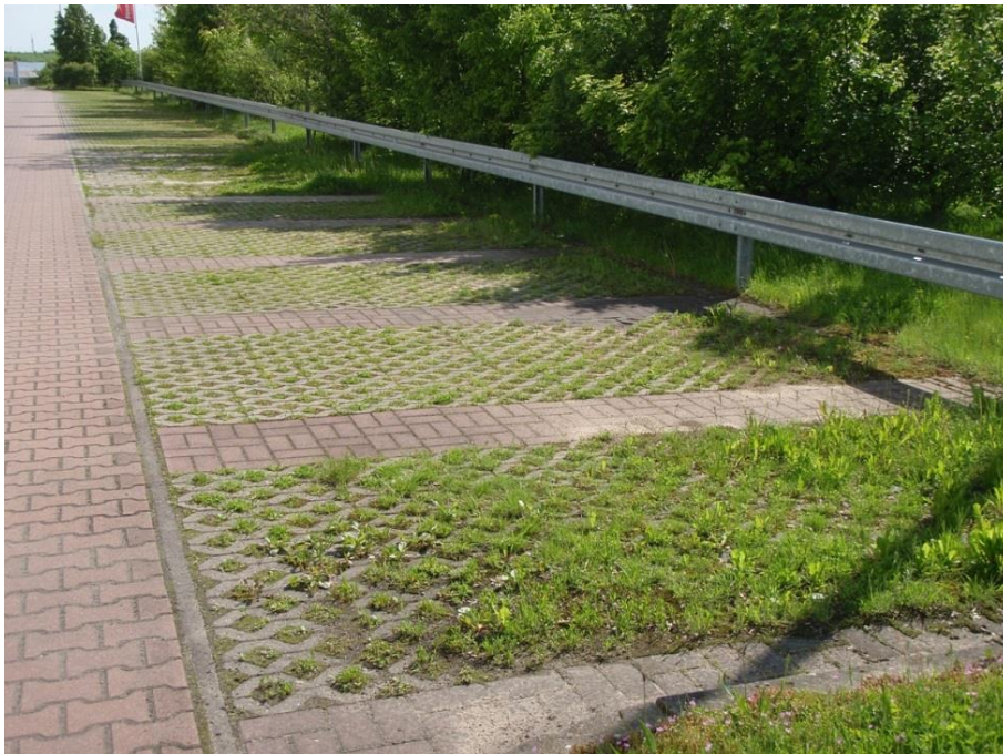
Figur 12. Infiltrerbara, gröna parkeringsrutor utformade med betonghålsten.
