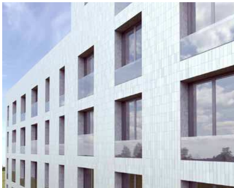
BILD 4:2:2 Fasadutsnitt gathuset med glasträcke och fönsterbröstning i fasadliv.
