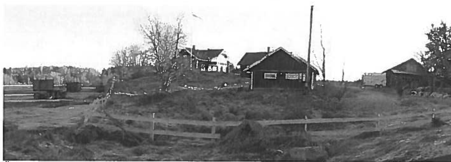
Älvsby gård på sin höjd. Till vänster ej planlagda tomter. Där har sprängning och avjämning ägt rum på mark som delvis varit utlagd som bevakningsobjekt för fornminne i anslutning till gården.
