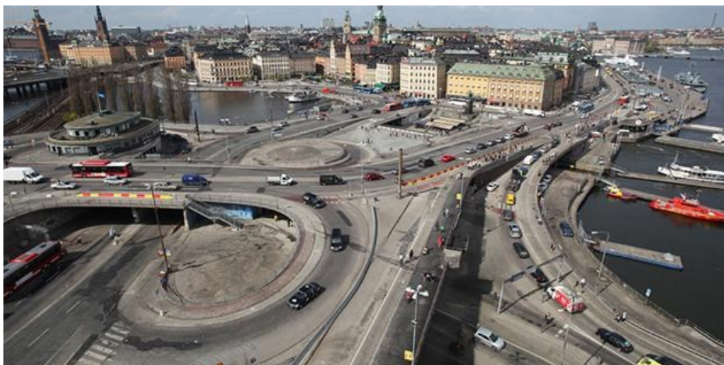
Figur 8. Vy över Slussen. (Källa: www.stockholm.se )
