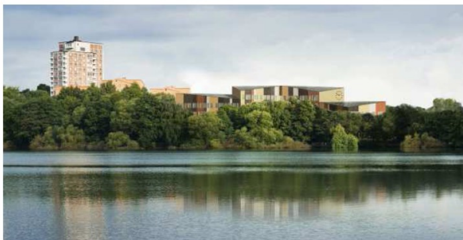
Vy från söder. Byggnaden inordnar sig i det övriga taklandskapet.
