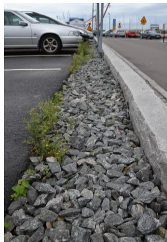
Växtbädd för parkeringsytas dagvatten (Sweco). Krossdike på parkeringsyta (Gbg Kretslopp och vatten). Vattengångar för större flöde (Sweco).
