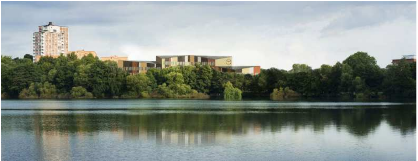
Vy från söder. Byggnaden inordnar sig i det övriga taklandskapet.
