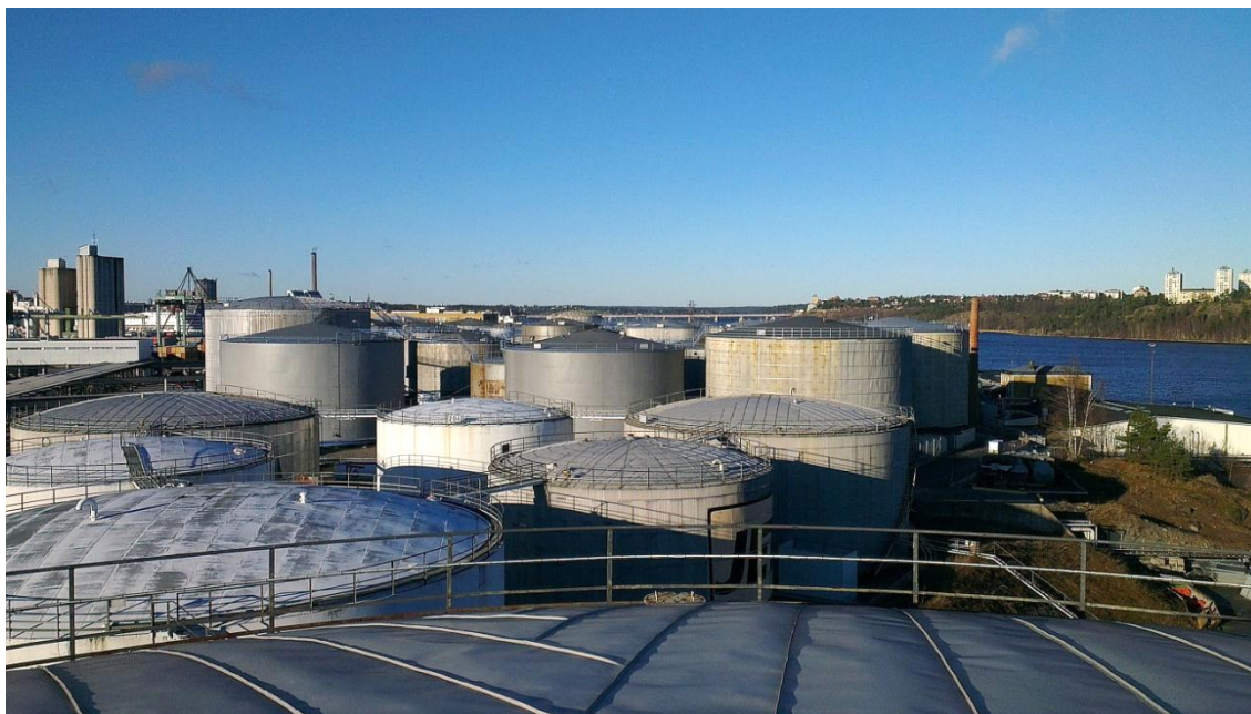
Utsikt över cisternparken i Louddens oljehamn, där miljöförvaltningen bedriver tillsyn över hanteringen av petroleumprodukter. Ett av syftena är att begränsa mängden oljeförorenat vatten till Lilla Värtan. Foto: Anna Vestman.
