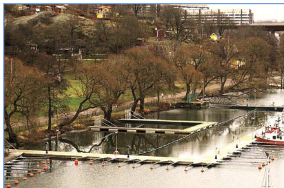
En skärmbassäng för rening av dagvattnet från Södra Stationsområdet och Hornstull har anlagts vid Tanto. Foto: Christer Lännergren.
