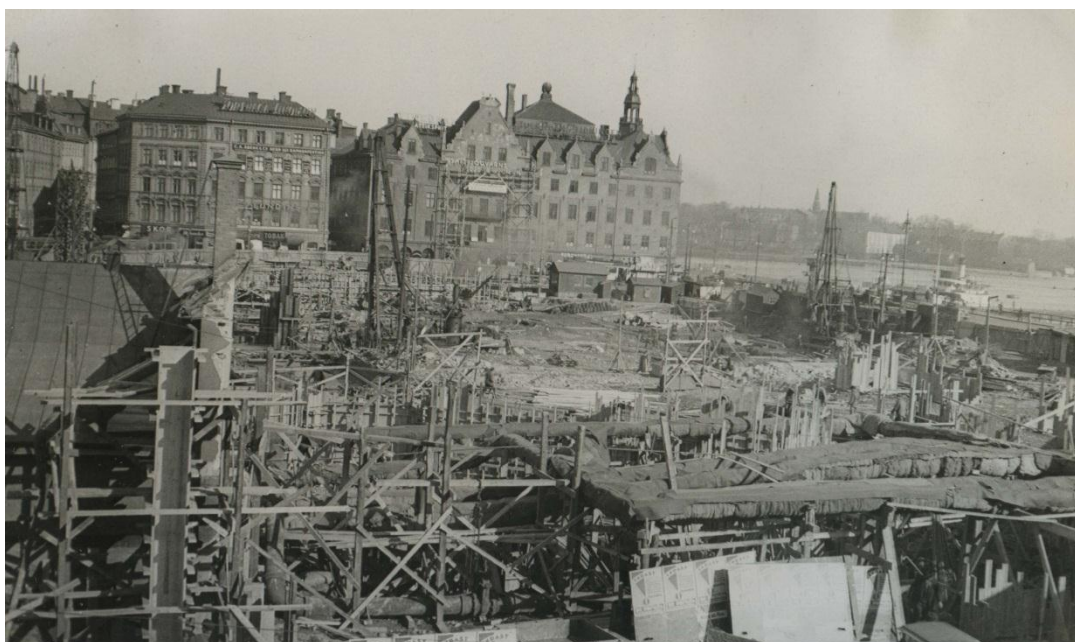
Slussen under bygget av Katarinatunneln 1933. Bild från Stockholmskällan
