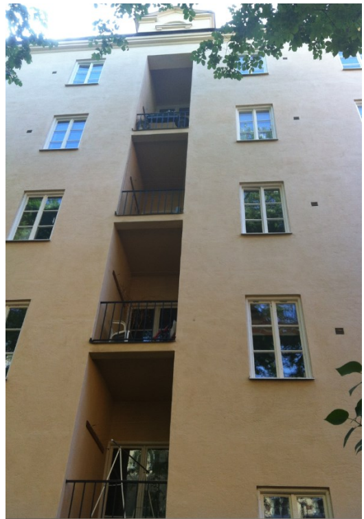
Enklare fasad in mot gården.
