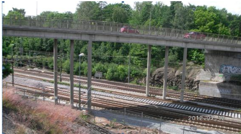
Bron över järnvägen sedd norrifrån
