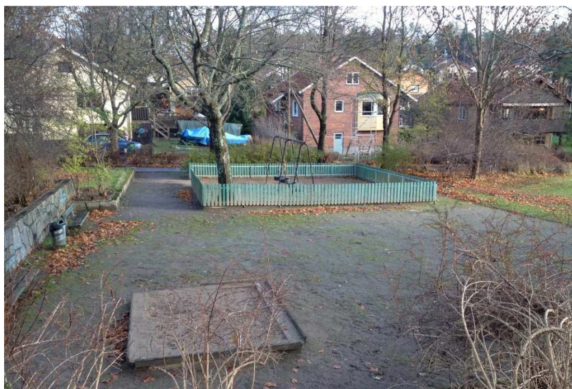
Bild som visar lekplatsen i planområdets norra del. I bakgrunden skymtar villorna i kvarteret Mandelbrödet. Vy mot öst.
