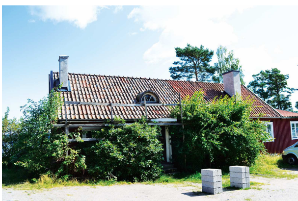
Figur 17. Västra fasaden av byggnad inom Stavsnäs 1:861.
