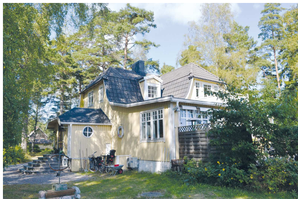
Figur 18. Huvudbyggnad inom Stavsnäs 1:182.
