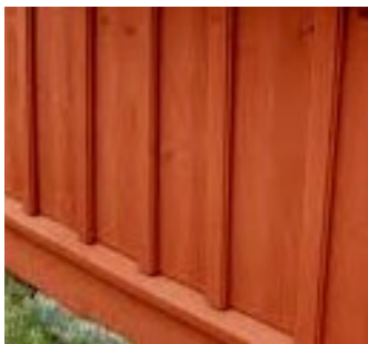
Exempel på avslutning av fasadpanel
