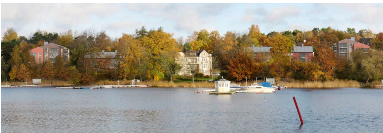
Vy från Farstaviken över Villa Strandvik (i mitten) flankerad av de föreslagna flerbostadshusen.
