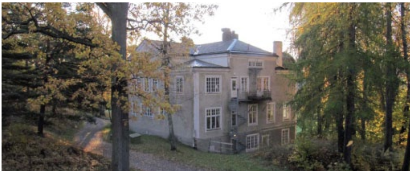
Villa Strandvik i befintligt skick; fotografier från 2011.
