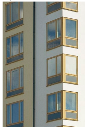
Blindfönster med fyllning av fasadglas
