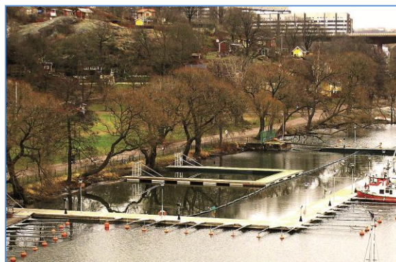
En skärmbassäng för rening av dagvattnet från Södra Stationsområdet och Hornstull har anlagts vid Tanto. Foto: Christer Lännergren.
