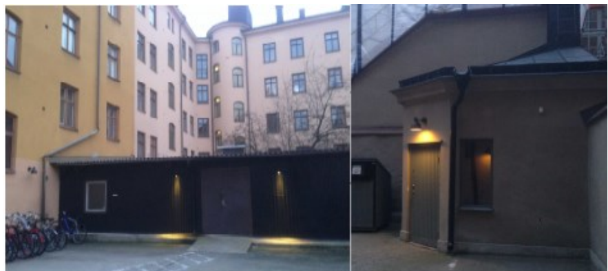
Till vänster: befintlig gårdsbyggnad som fått rivningslov för att ge plats åt ny gårdsbyggnad. Till höger: befintlig gårdsbyggnad som idag används som soprum.
