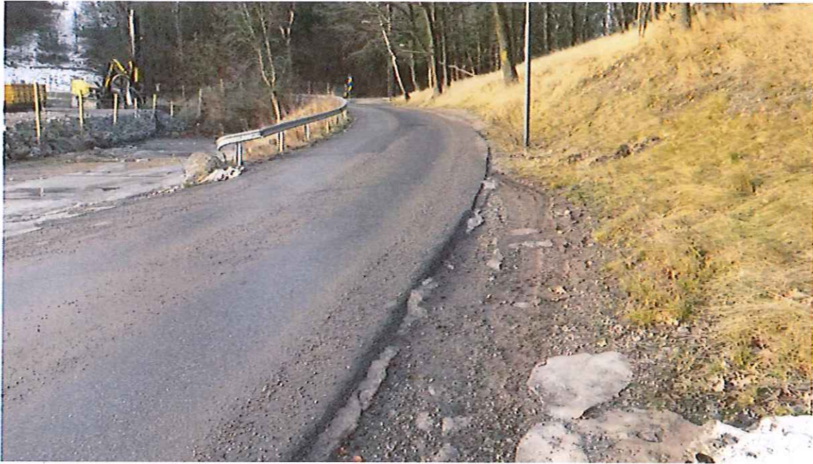
I början av vägen saknas gångbana. Här är Sättravarvsvägen så smal att bilar inte kan mötas.
