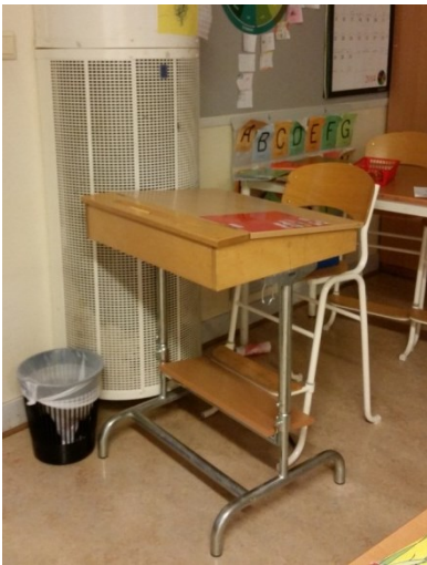
Figur 2. Arbetsbänk invid deplacerande don. Deplacerande don håller en temperatur som är ca 4 grader lägre än rumsluften. Man bör inte sitta så när ett sådant don.
