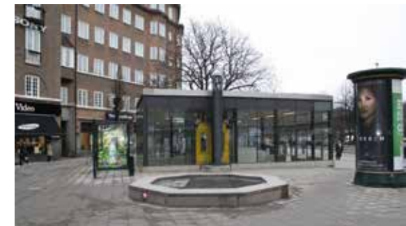
Figur 4.18. Exempel på ventilationstorn samt tryckutjämningschakt i förgrunden.
