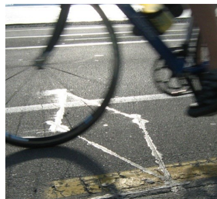
Cyklar räknas automatiskt av slingor som ligger nedfrästa i asfalten.
