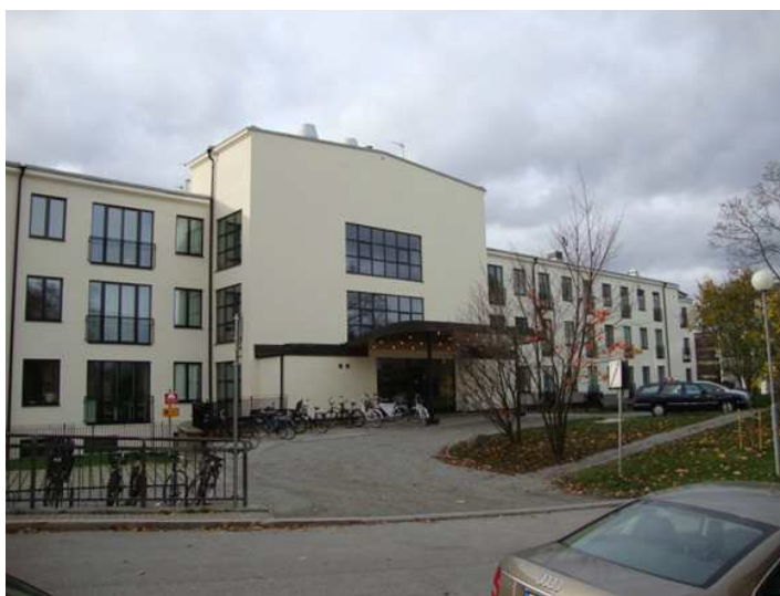
Entrén till den befintliga byggnaden vid Ruddammsbacken. Foto: Stellan Ridderstrand
