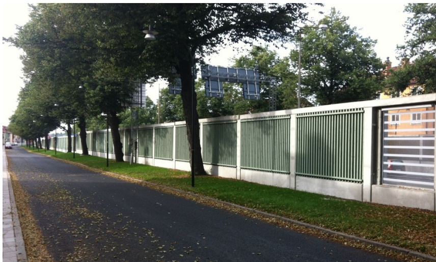
Färdigmonterad skärm sedd från lokalgatan
