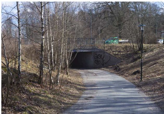
Tunnel under Perstorpsvägen som avses att tas bort
